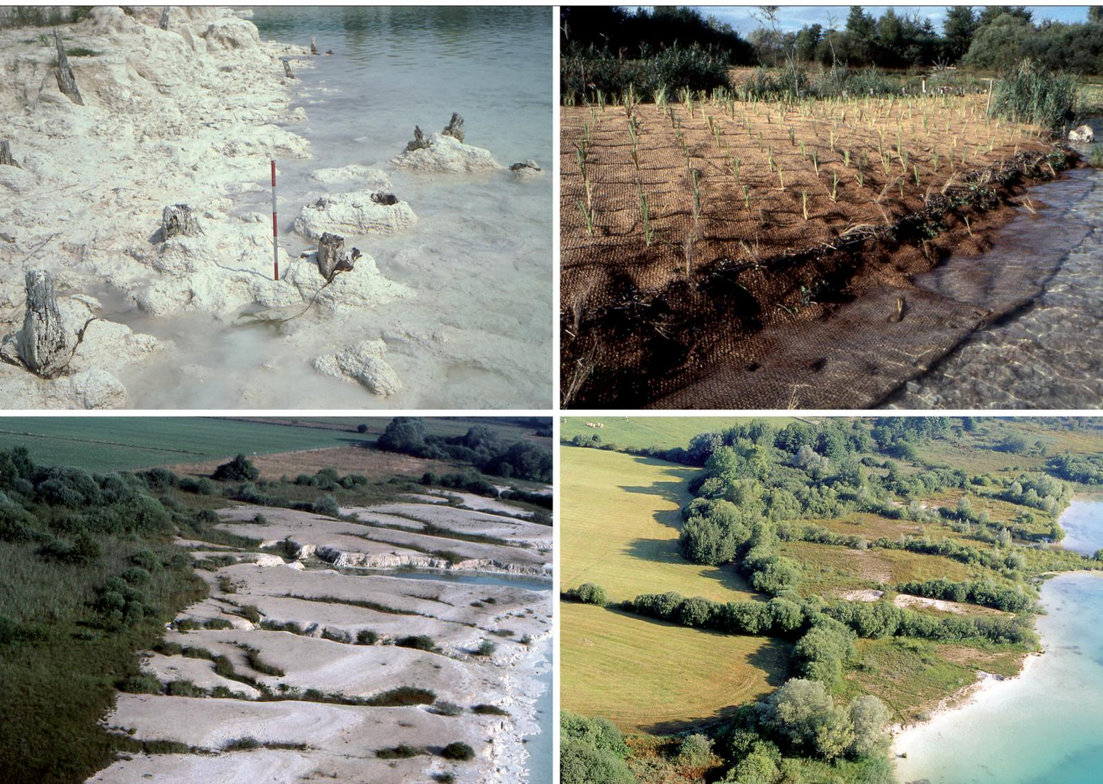
**Fig. 11** L'érosion littorale (à gauche) et la protection des rives par géotextile et revégétalisation, en 1995. Réalisation du Service régional des Monuments historiques de Franche-Comté. Photos P. Pétrequin.
